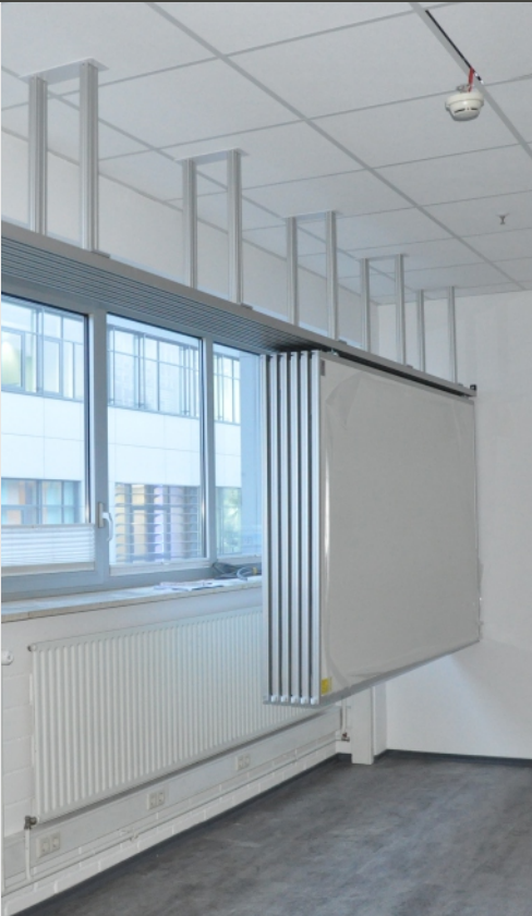
Befestigung verdeckt, ca. 1.500 mm oberhalb der Tafeln
